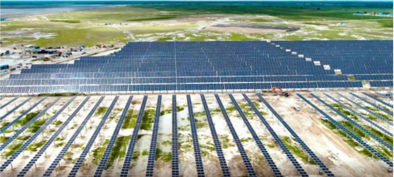
该项目采用正泰新能源自主研发生产的405Wp高效光伏组件，其中60兆瓦双玻双面组件，40兆瓦单晶单玻组件，并采用10度平斜单跟踪支架，最大程度的提高发电量。预计运营期内平均年上网电量约为190942MWh，相应年等效满负荷发电小时数约为1736h，相当于每年节约标煤约58237.31t，减少二氧化硫排放约584.28t，二氧化碳排放约155426.79t，氮氧化物排放约504.85t，碳粉尘约51936.22t，25年运营期累计发电量约为4773559MWh。
