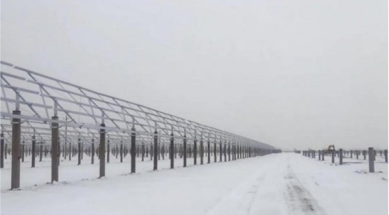
白城二期项目建设过程中，项目组克服重重困难：为了便于后期农作物的种植，项目设计时特意加大了组件离地高度，最高点甚至超过5米，全部需要搭脚手架施工，增加了施工难度。另外，受疫情影响，材料供货和人员进场都有延期，工期严重受影响，但项目组依然通过各种方式，调动一切力量，在计划时间内完成并网发电。值得一提的是，项目组还克服了冬季施工的艰难条件，甚至在零下30度的严寒天气下依然照常施工。负责正泰白城一期和二期建设的项目经理喻泽君表示，项目建设确实让他经受了非常大的压力，包括疫情、工期、施工条件等等，但同时压力也是动力，项目能按时并网，一切辛苦都值得。
