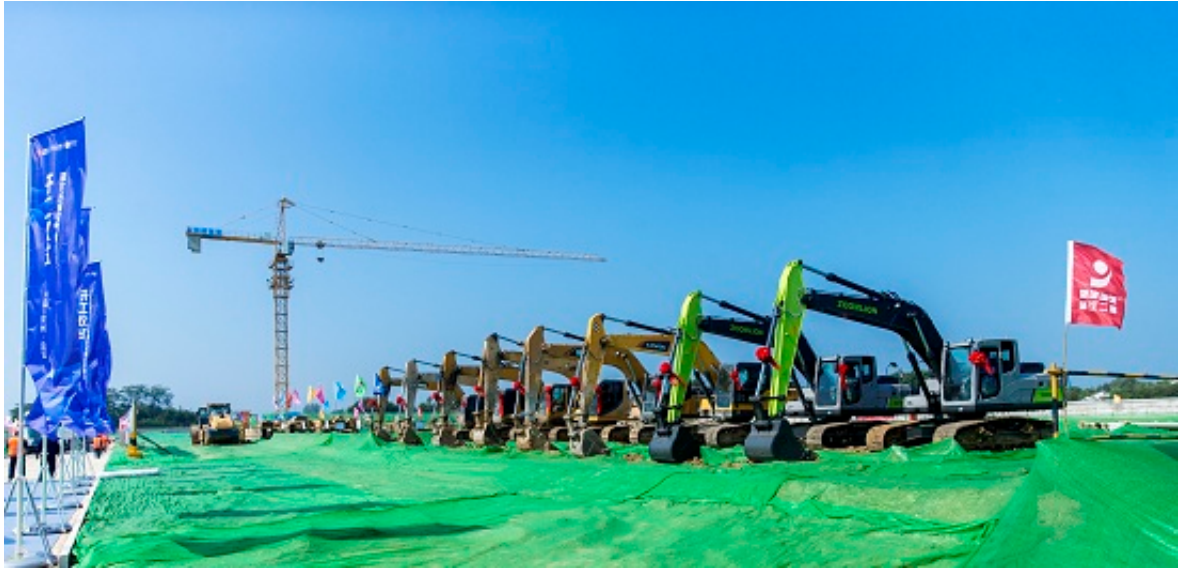
工程施工现场
