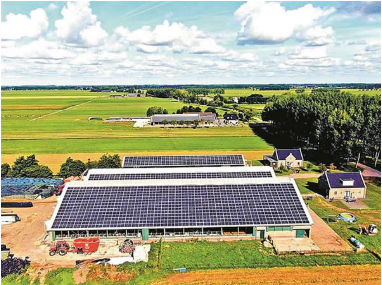
古瑞瓦特位于荷兰的光伏电站并网运行。
