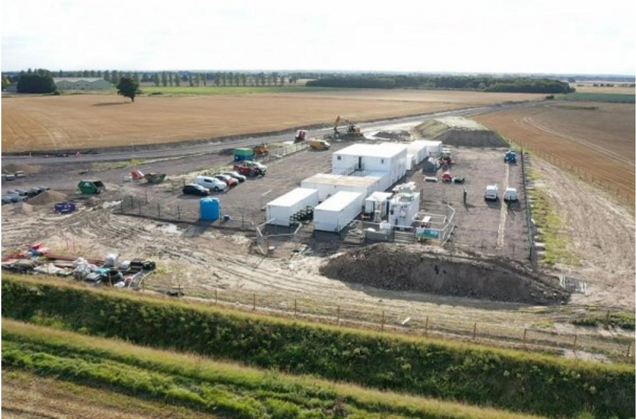
燃料电池系统包含216kWh的电池存储，用来平滑电力需求高峰，并提高系统的效率。电池存储也意味着，如果氢供应中断，系统的输出将不受影响，并能自主供电数小时。
