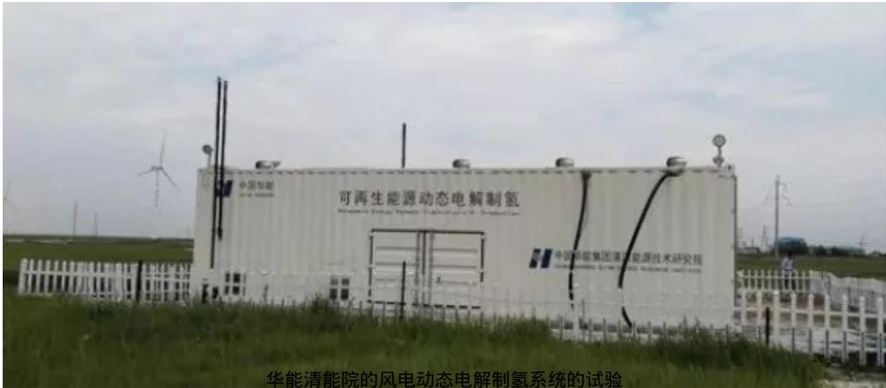
华能清能院的风电动态电解制氢系统的试验
