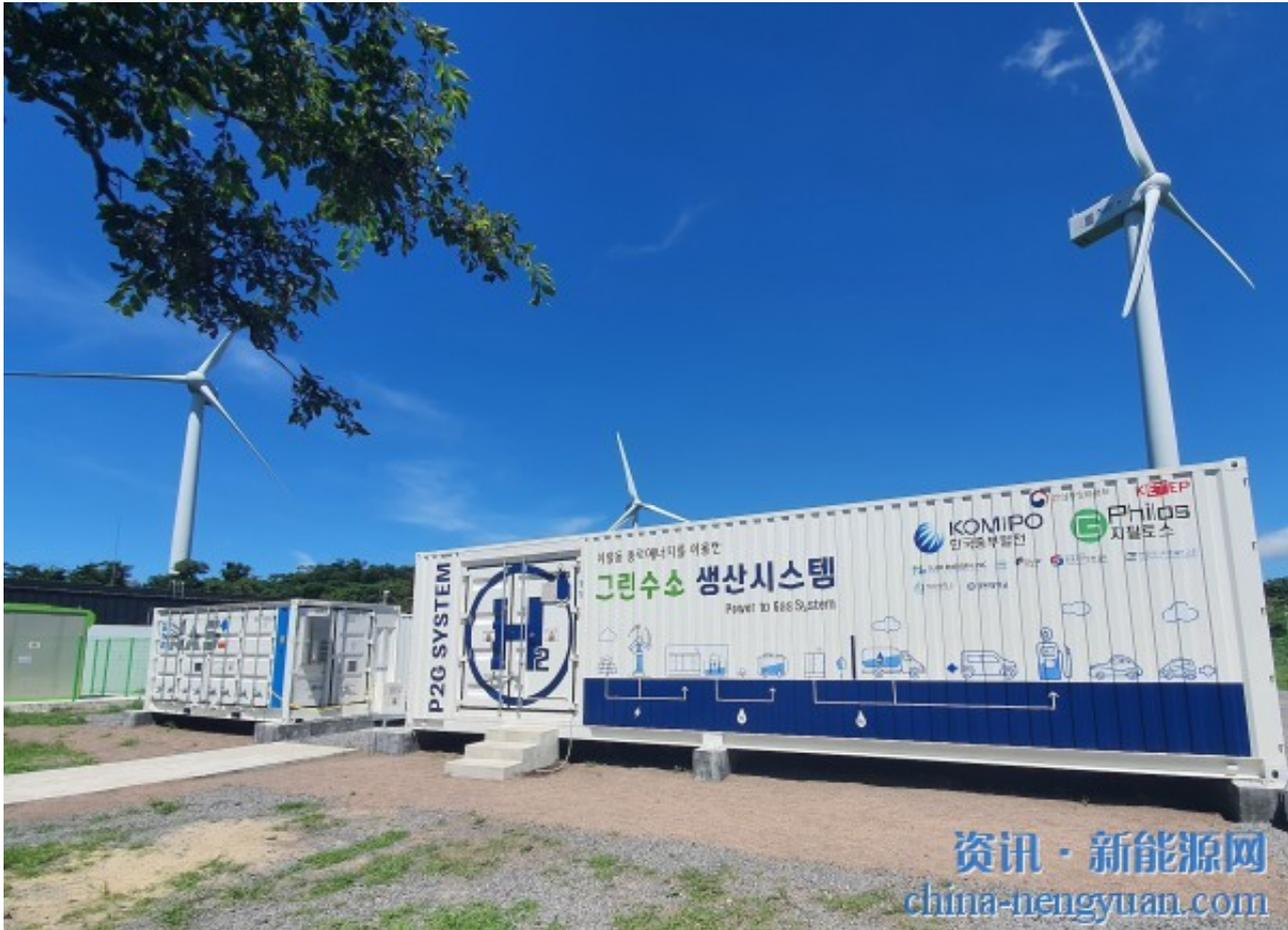
Sangmyung21MW风力发电场的power-to-gas(P2G)系统包括NGKs NAS电池作为缓冲，以确保在风力发电不稳定的情况下仍能稳定产氢。图片：BASF NB
