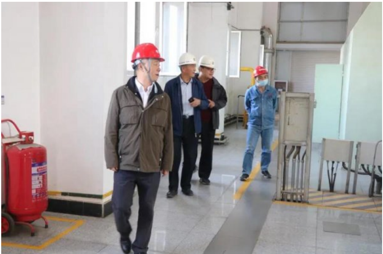
调研组对平邑县鲁电生物质发电有限公司防治掺煤工作给予充分肯定，要求进一步建立防治掺煤烧炭长效工作机制
