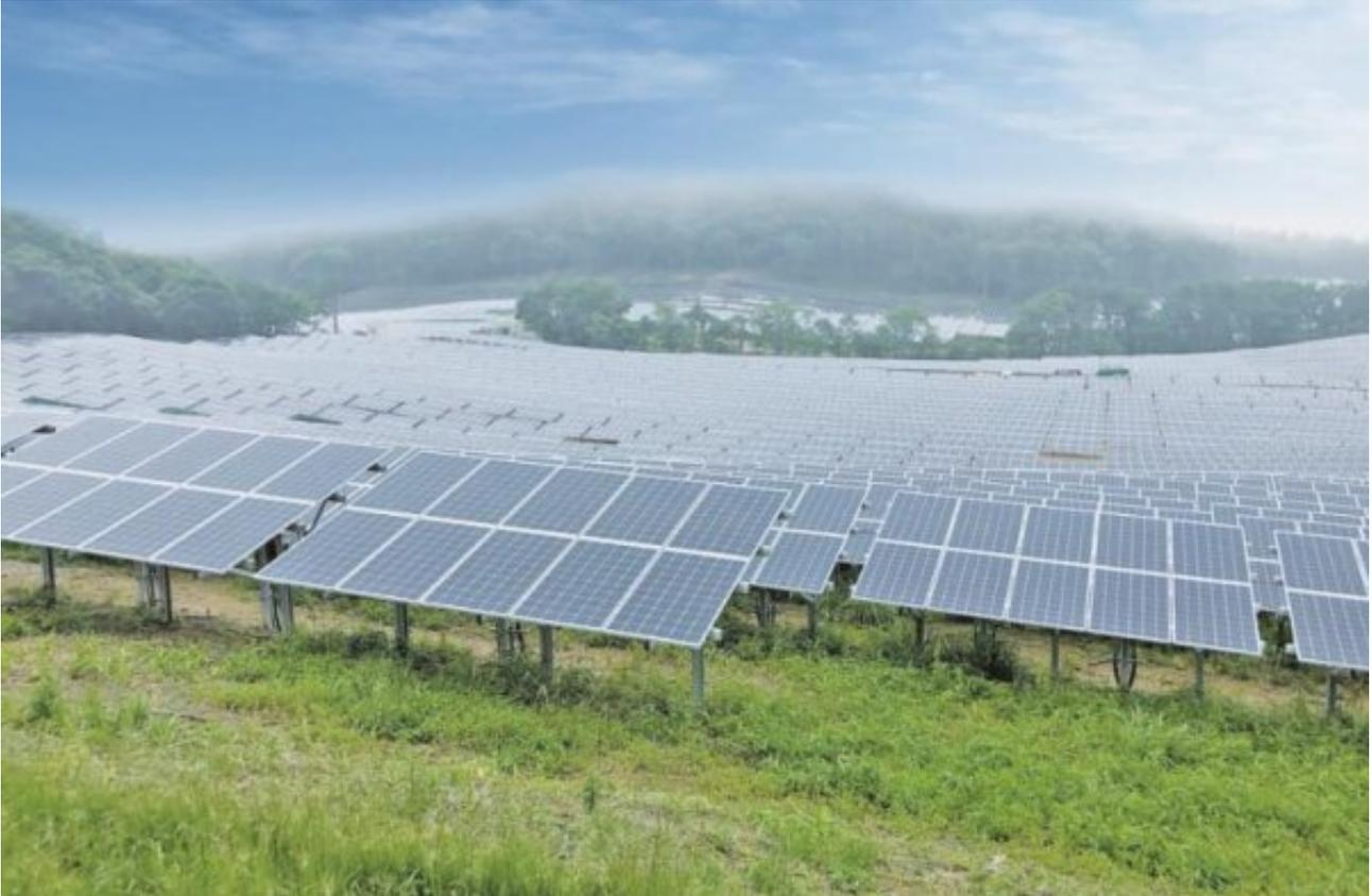
日本福岛40MW光伏地面电站位于福岛县川内村已经废弃的两处闲置区，占地52公顷。川内村属湿润大陆性气候，冬季寒冷，降雪量大。基于当地自然环境条件和施工要求，清源股份为该光伏电站提供地面光伏支架产品Solar Terrace II F。该产品适用于平地、东西朝向斜坡，采用专利TR轨道设计，提升载荷能力，使该系统足以对抗大风及暴雪等自然考验。
