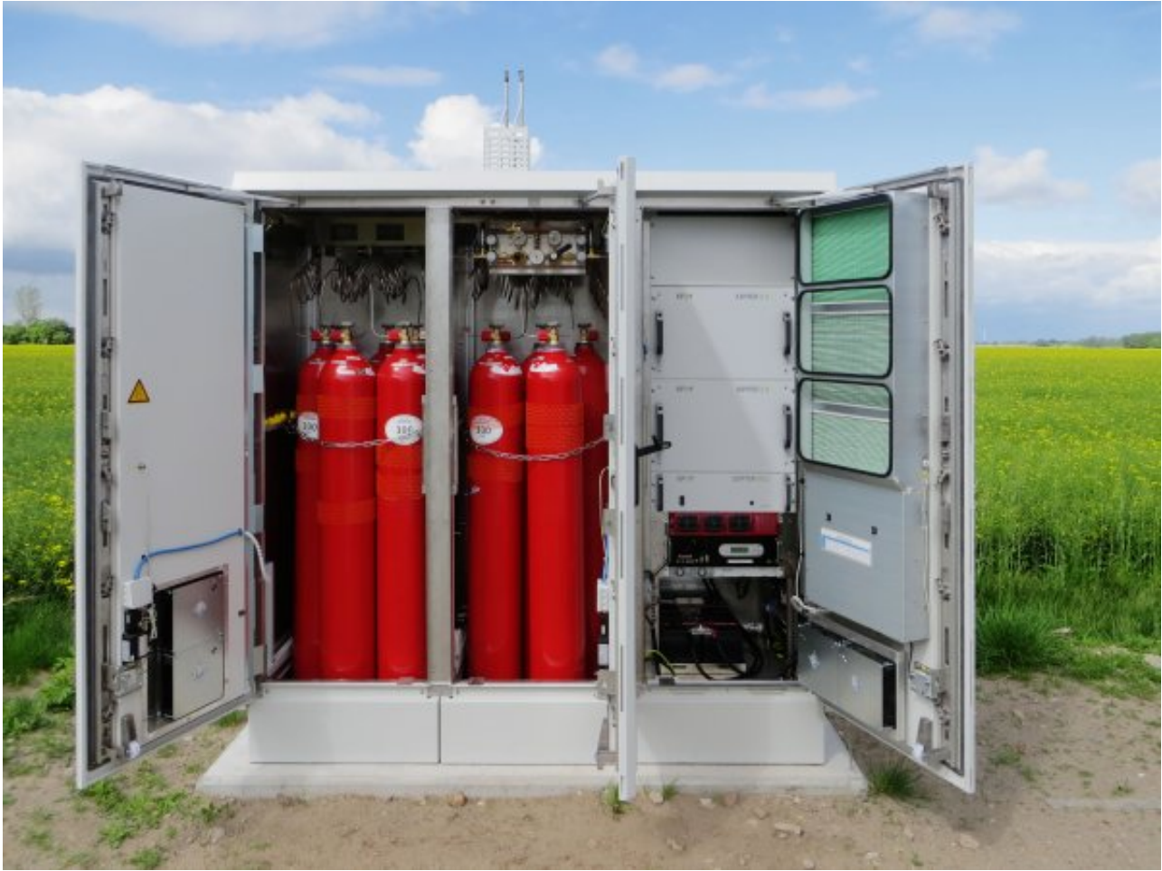
控制柜，最多四个EFOY JUPITER模块
