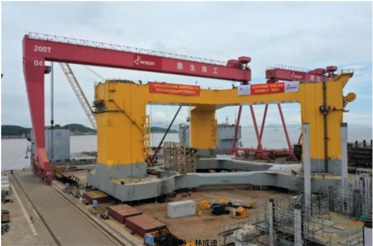
该平台整体型宽91米、型深32米、设计吃水13.5米，可抵御南海复杂且恶劣的极端海况。
