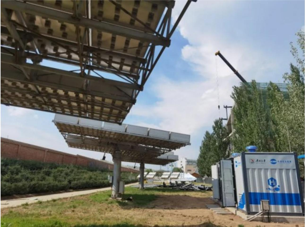
该系统装置由太阳能光伏发电、电解水制氢、储氢罐、燃料电池热电联供系统组成，不仅能解决新能源消纳问题，还能为偏远地区供热供电，对天然气掺氢的应用场景也有重要的示范作用。
