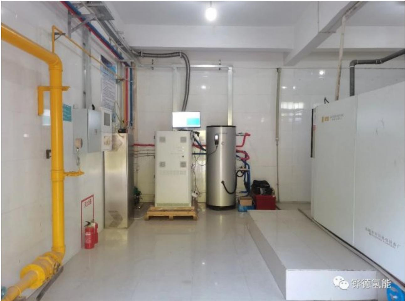
本示范项目所采用的热电联供系统由铎德氢能自主研发生产，拥有多项国家发明专利和实用新型专利。天然气重整制氢型的氢燃料电池热电联供系统是以天然气重整制氢装置和电堆为核心，天然气重整置换反应产生氢气，氢气进入电堆，电堆发生电化学反应产生电流，经过整流之后，实现稳定的电力输出，同时把重整器和电堆的余热进行置换，完美高效的实现热能的输出。
