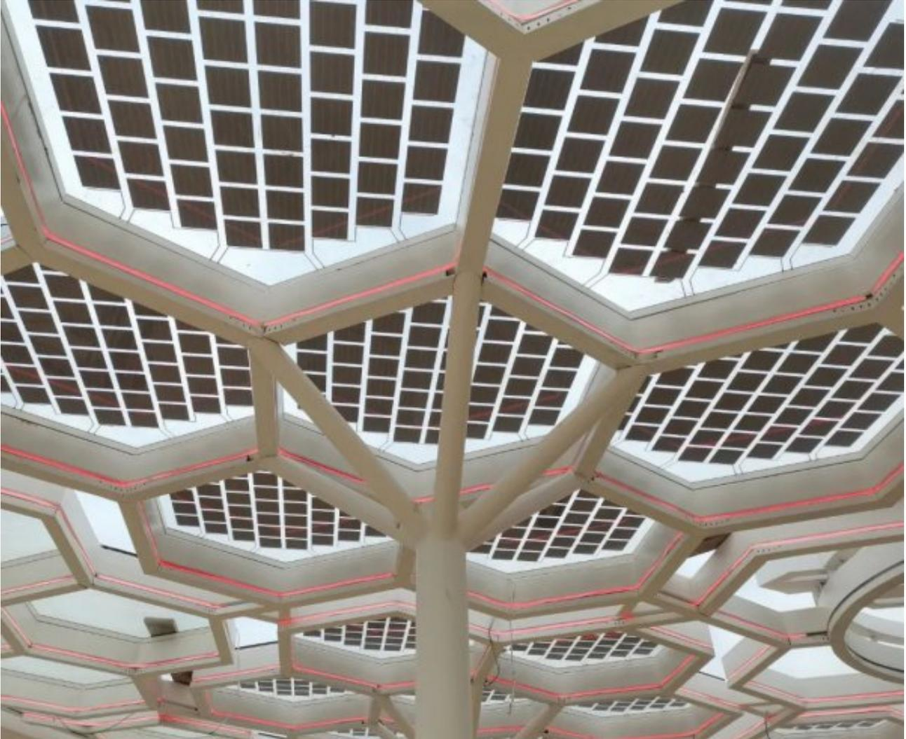
该项目总装机容量36千瓦，预计年发电量约4万度，所发电量全部自用。“整个中交科创城包括基础设施、公共服务设施、产业办公、配套住宅、商业开发、城市运营及产业发展服务等，力争打造成产城融合、站城一体、智能高效、低碳环保的城市标杆。因此，项目之初就将光伏发电纳入规划，通过使用光伏来提高整个项目的清洁用能比例，降低建筑能耗。”中交科创城相关负责人介绍。
