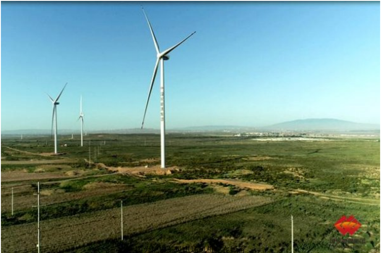
图为国神风电场风机正在运行
