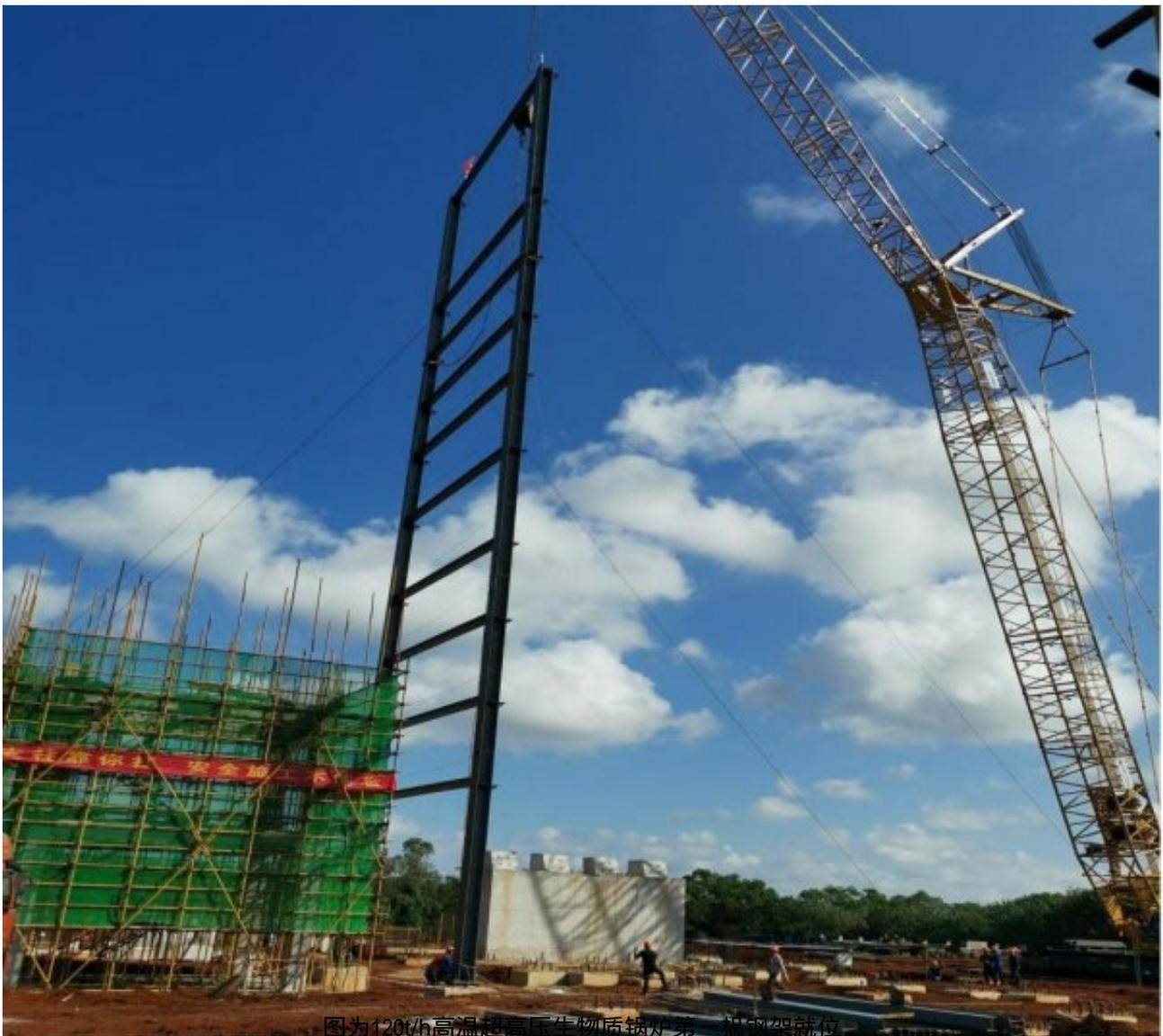
图为120t/h高温超高压生物质锅炉第一榀钢架就位
