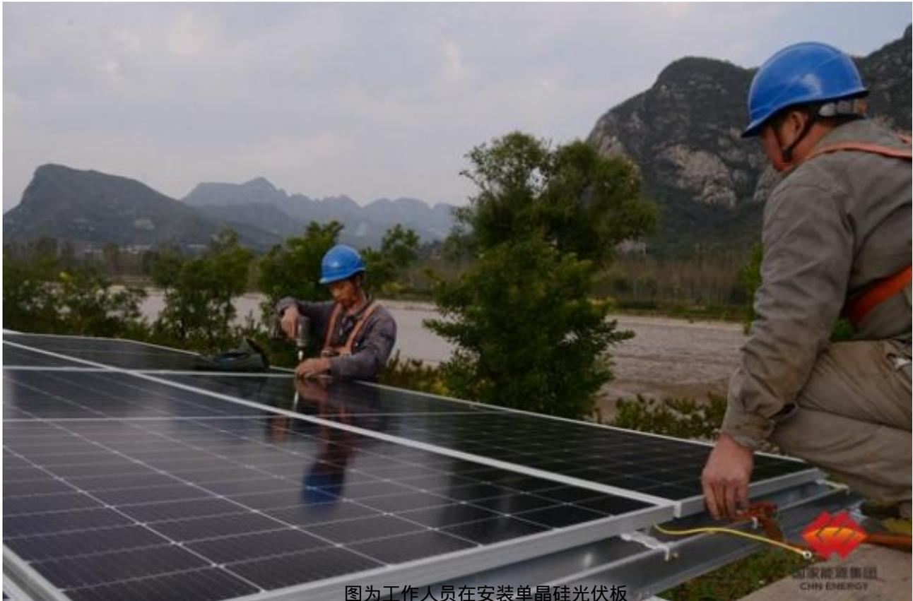
图为工作人员在安装单晶硅光伏板
