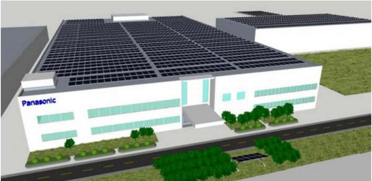
项目利用三洋能源（苏州）有限公司厂房屋顶建设分布式光伏发电装置，总装机容量为2.74MW，预计投资额1078.7万元。项目采用“自发自用，余电上网”，建成后年均发电量可达264.2万度，相当于替代标准煤950吨。建成后每年可减少二氧化碳排放量2634吨、二氧化硫排放量79吨、氮氧化物排放量39吨、烟尘排放量718吨，相当于植树1462棵，为城市“减负”、环境“减压”发挥了积极的推动作用。
