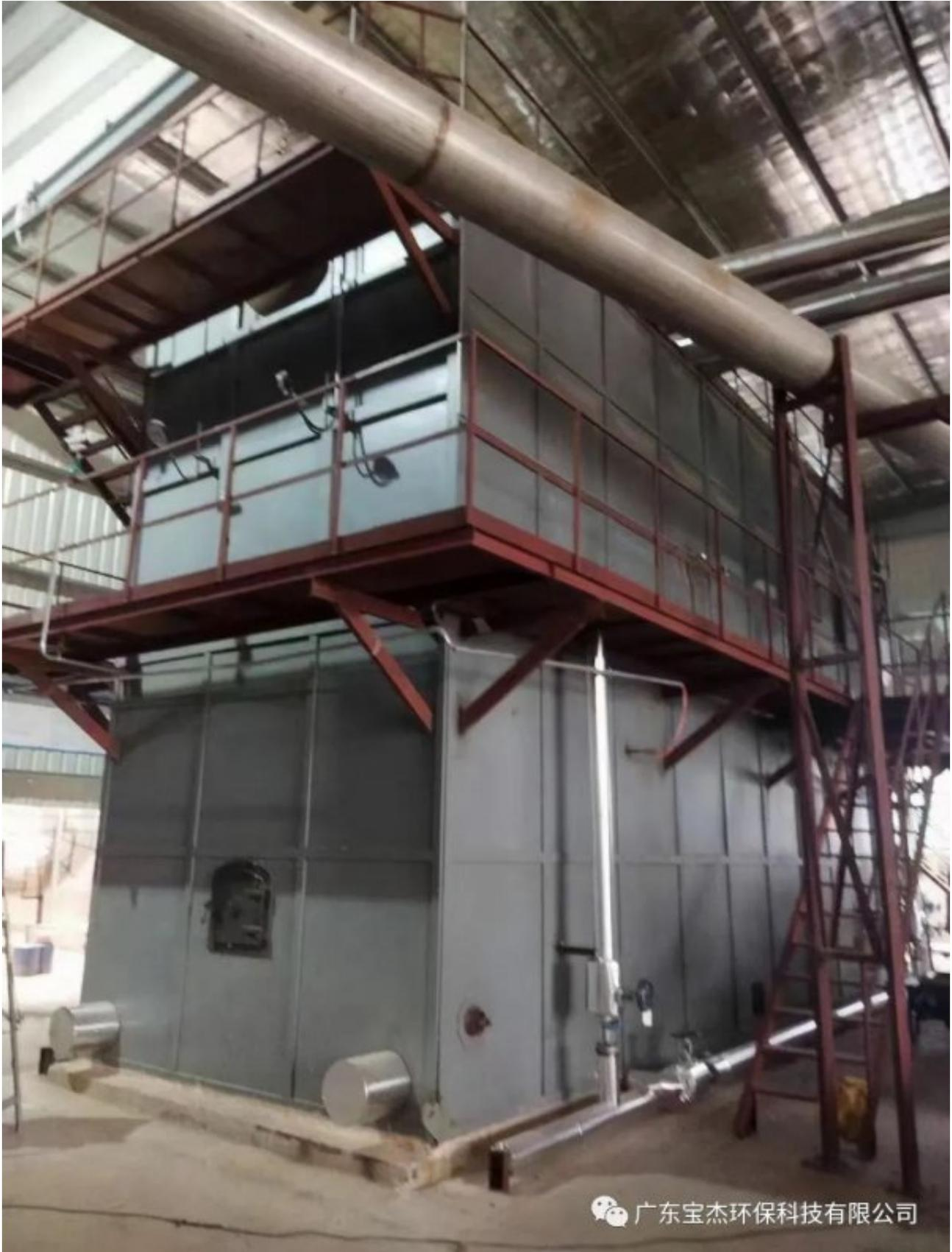
2021年11月，国内第一家食用菌企业使用生物质气化炉供热的项目在福建正式投产运行。该项目使用的生物质气化炉为广东宝杰环保科技有限公司生产的15吨生物质气化设备。
