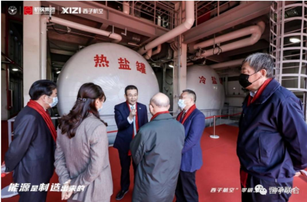
在西子航空厂区内，有两个直径约4米、长约13米的储盐罐，单个能装280吨熔盐。目前这两个储盐罐的总储热量能达到100GJ，年供蒸汽超过10000t。“零碳工厂的背后，更重要的是储能技术的应用。”侯晓东总经理介绍说，像大规模熔盐储能技术，杭锅已经研发并实践了十年时间。相比于其他储能技术，这种储能技术可以实现大规模、高参数的应用场景。据悉，杭锅熔盐储能技术的热电联供效率能达到90%。
