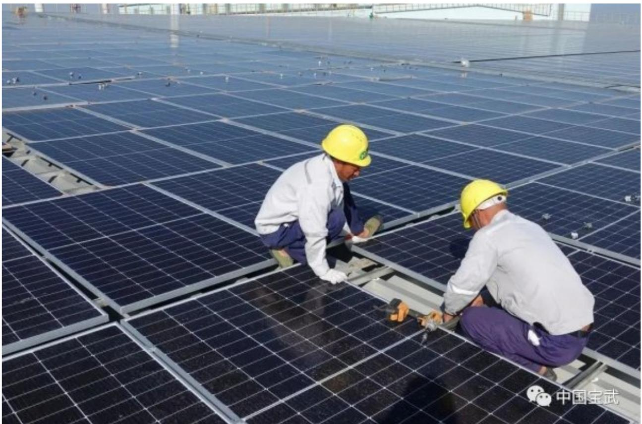
湛江钢铁光伏发电（一期）工程建设做足了前期准备。三方根据厂区屋顶的情况，就承重结构、安装方式、施工及运维等方面做了详细的设计，合理高效利用屋顶闲置空间，保证发电效益。工程自2021年9月15日正式开工，历经现
