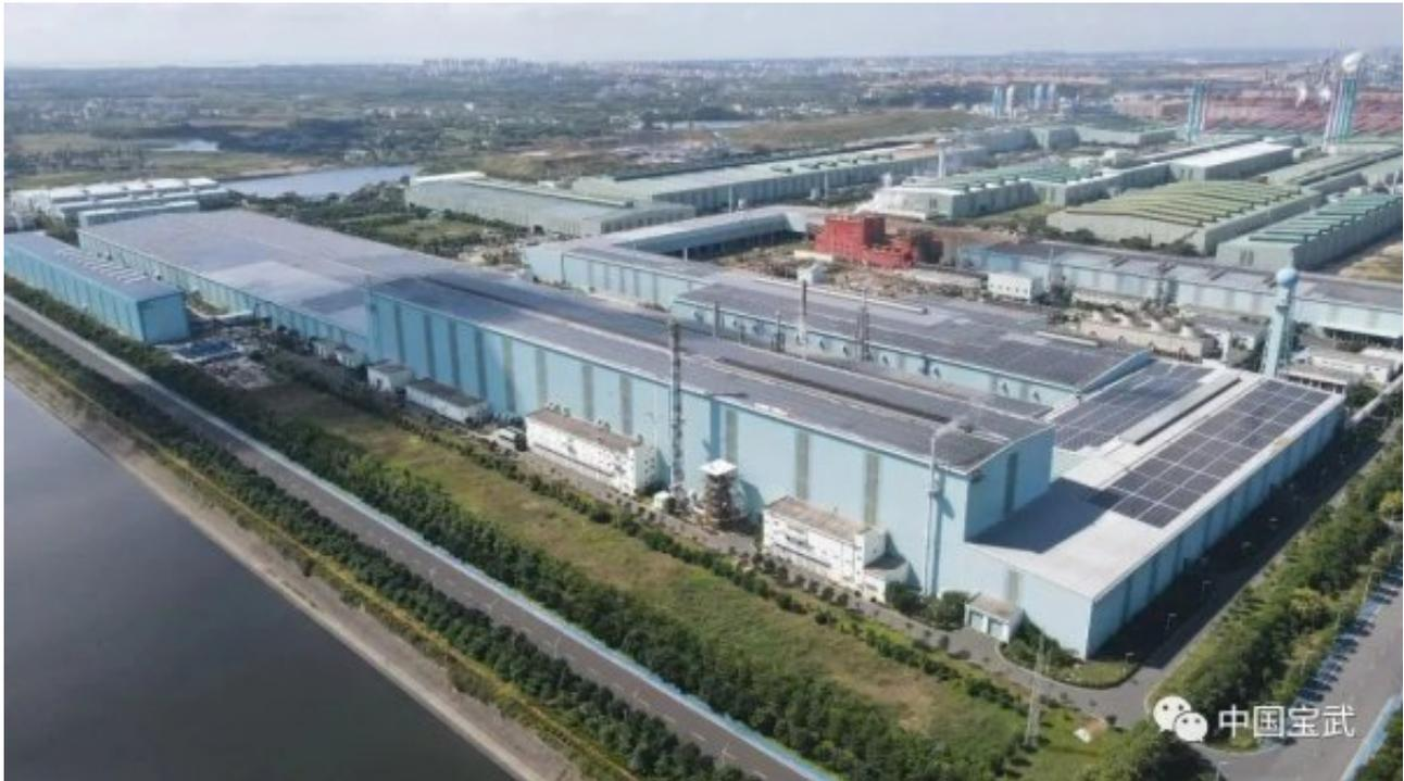
湛江钢铁光伏发电（一期）工程是在钢厂房屋面上安装光伏组件，利用4200mm厚板、2250mm热轧、1550mm冷轧、2030mm冷轧、铁路成品库等宽阔厂房屋面，共安装了100981块单晶硅光伏板，总面积达41.25万平方米，总装机容量48.2MW，年平均发电量4755万kWh，相当于每年节约标煤1.57万吨，每年可减排二氧化碳4.69万吨，为湛江钢铁源源不断地输送绿色电能。
