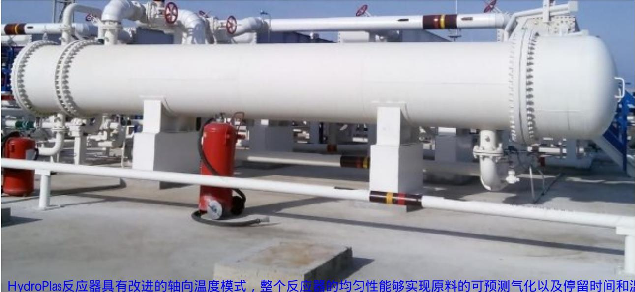
HydroPlas反应器具有改进的轴向温度模式，整个反应器的均匀性能够实现原料的可预测气化以及停留时间和温度计算的灵活性。
