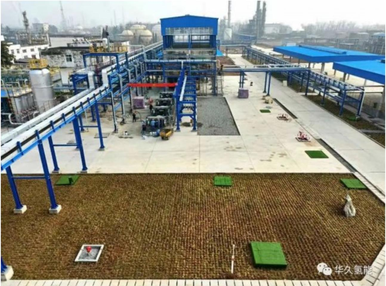
华久氢能项目位于洛阳市孟津区吉利华阳产业集聚区，依托石化园区内充足的氢气资源，经提纯、液化、加压向市场供应清洁能源。该项目采用国际领先的液氢技术和装备，自动化程度高，装置安全、可靠、经济、高效。项目总用地80亩，投资3.068亿元，项目建成后将是国内规模最大的商业化民用液氢项目。一期设计高压氢4000吨/年，2021年12月建成。二期建设液氢2700吨/年、高压氢3700吨/年，计划2023年6月投产。
