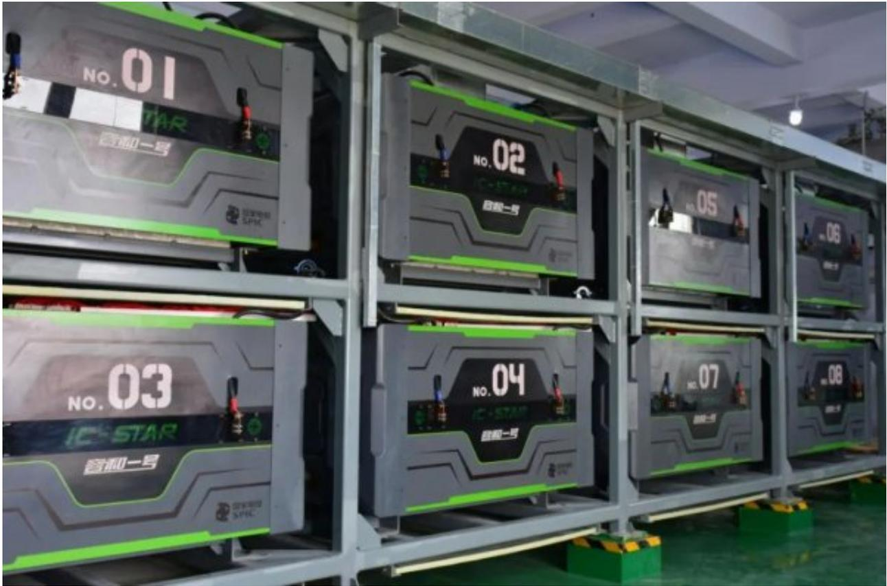
2017年，国家电投布局储能产业，进军铁-铬液流电池技术研发领域，开启了能源央企进军储能产业的先河。五年来，国家电投持续加强与科研机构、高校的合作，在技术研发领域稳步向前，孵化北京和瑞储能科技有限公司，研发出第一代具有自主知识产权的铁-铬液流电池储能产品——“容和一号®”，实现了铁-铬液流电池储能技术的产品化、标准化、产品示范验证及产线建设，打造了完整的铁-铬液流电池产业链，并在内蒙古霍林河启动全球首个兆瓦级铁-铬液流电池储能示范项目建设，预计今年年底投产。该项目投产后将再次刷新全球铁-铬液流电池储能系统最大实证容量纪录。
