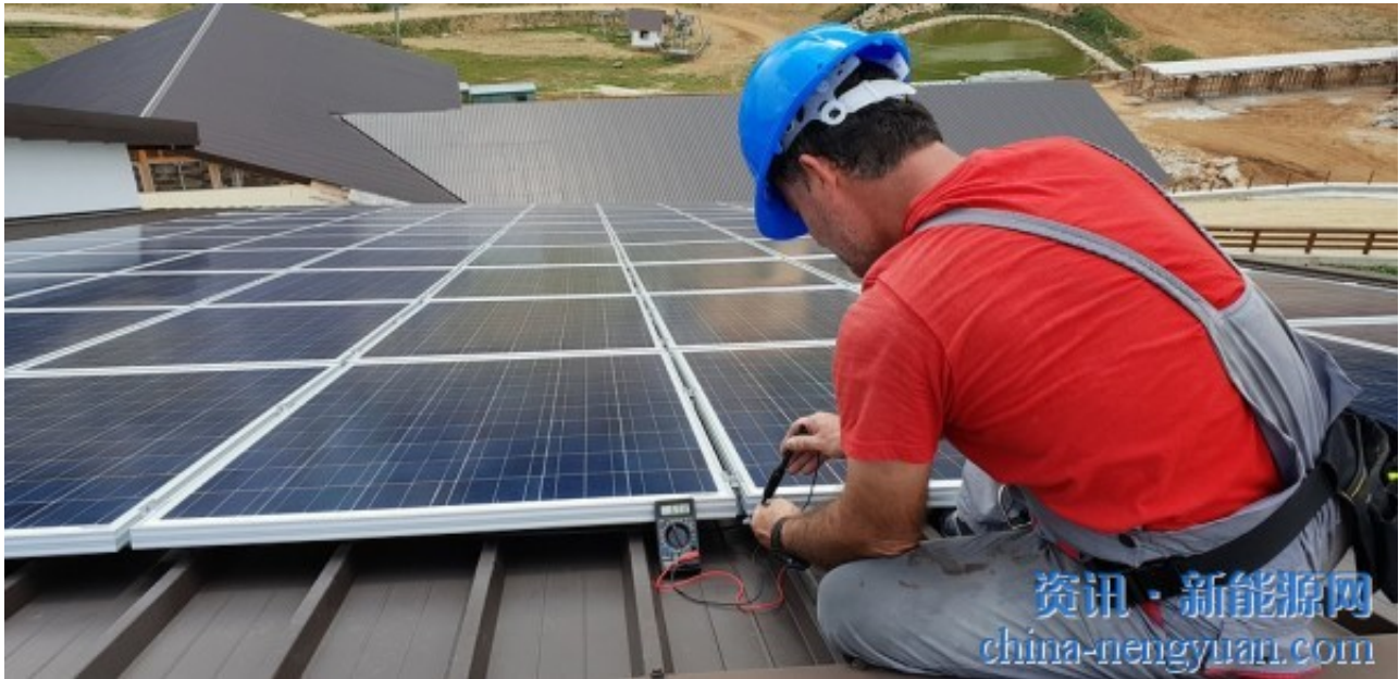
一名技术人员在屋顶检查太阳能电池板。
