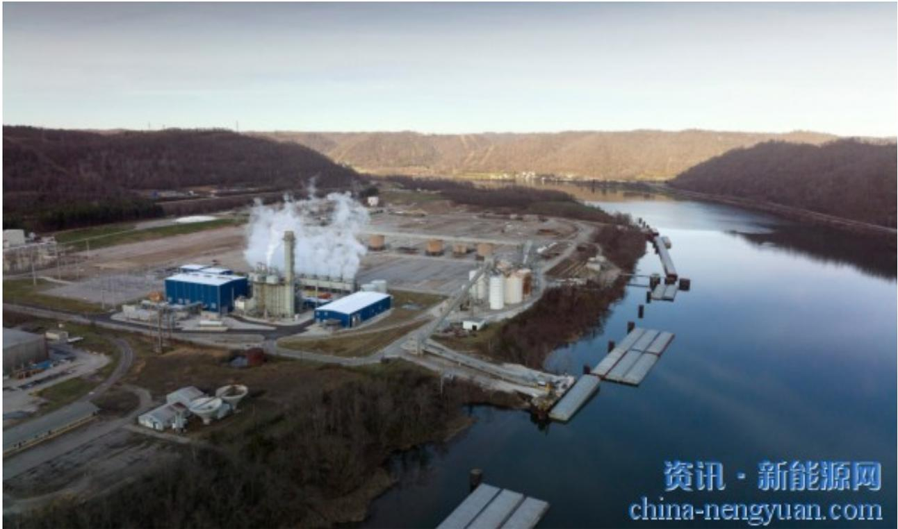
位于俄亥俄州汉尼拔的Long Ridge Energy终端电厂(Long Ridge Energy Terminal Power Plant)在3月底进行了成功的测试后，目前正在燃烧一种混合氢燃料，这是该工厂向无碳转变的重要一步。
