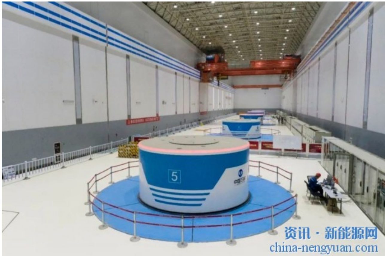
长龙山抽水蓄能电站5号机组。CTGC
