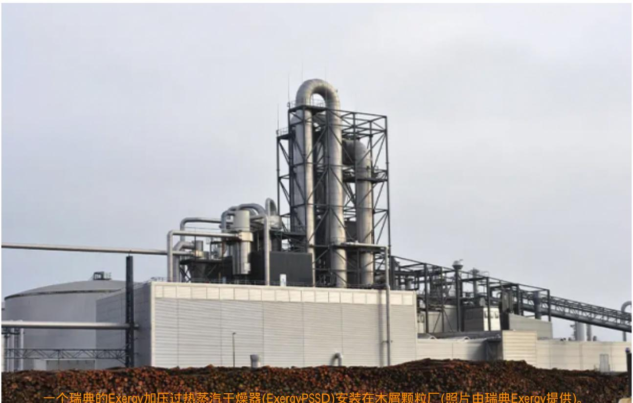
一个瑞典的Exergy加压过热蒸汽干燥器(ExergyPSSD)安装在木屑颗粒厂(照片由瑞典Exergy提供)。
