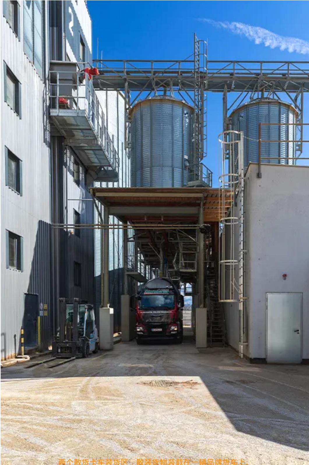
两个散货卡车装货区，散装货物装载在一辆品牌货车上。
