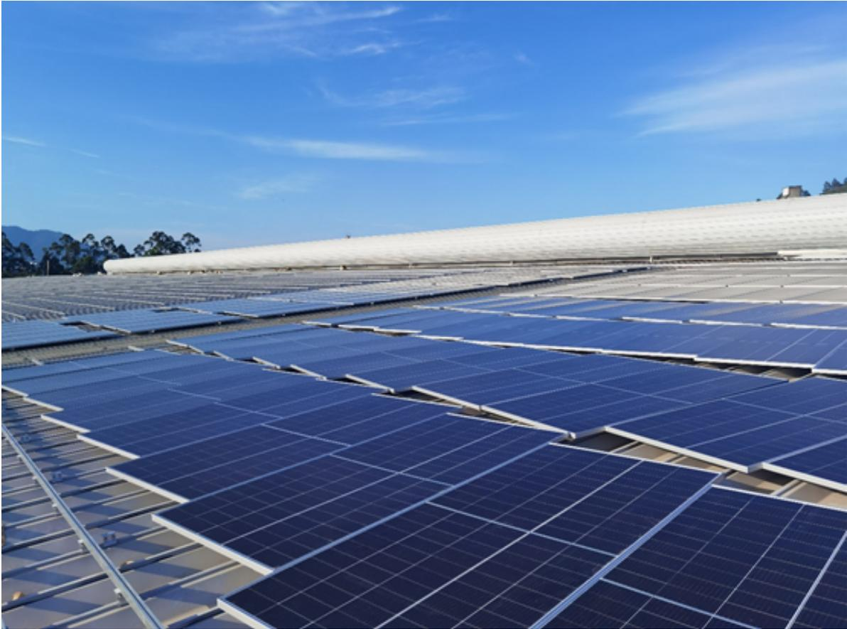
作为不锈钢行业头部企业，福建吴航不锈钢制品有限公司创办于1993年，系中外合资企业，占地面积110万平方米，拥有不锈钢原料加工；炼钢；热轧不锈钢钢带、线材；冷轧薄带，冷拔精线、机修等车间。此次项目全部采用东方日升TITAN泰坦系列550W组件，并搭配高强度合金钢边框，是目前华南地区单体最大的彩钢瓦屋顶分布式工商业项目。
