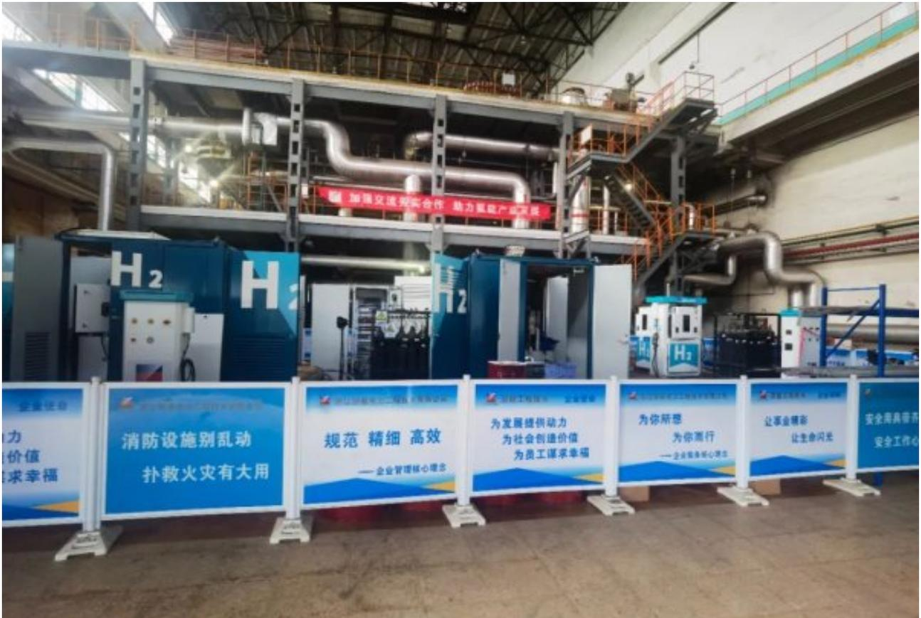
本次系统联合调试首次在公司自主集成的加氢站设备上应用了公司自主研发的加氢站控制系统，实现了零的突破。本次采用的控制系统是省内首套具有完全自主知识产权的加氢站控制系统，获得了浙江省电力学会科技进步二等奖，其以全部国产化控制芯片为支撑，通过采用PLC和单板电脑深度融合实现了对加氢站软硬件的适配。本次调试验证了公司自主集成加氢站硬件与自主研发加氢站控制软件的适配，为后续公司加氢站建设业务打下了坚实基础。（周雨轩）
