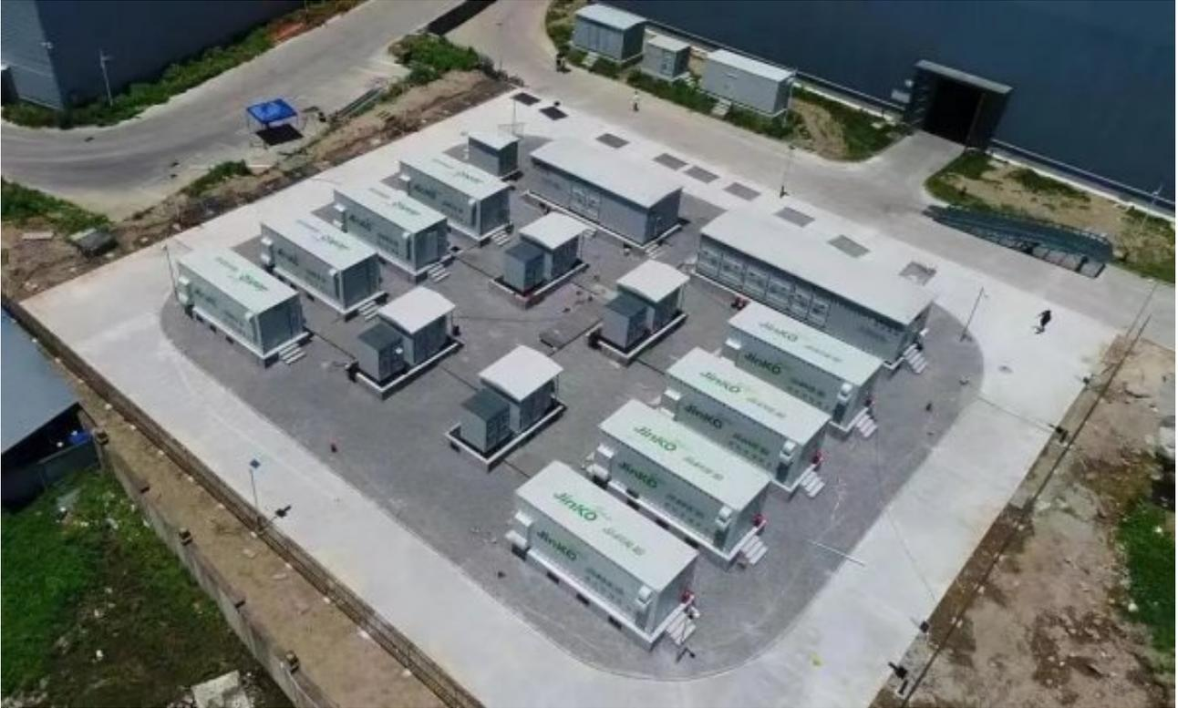
项目采用能量型电池组作为储能元件，不但可以降低电网的峰值负荷，有利于电网的安全运行，还能产生巨大的经济效益。投产后，项目已经参与到当地电网的需求侧响应中，为夏季高峰电网平稳运行做出重要贡献。
