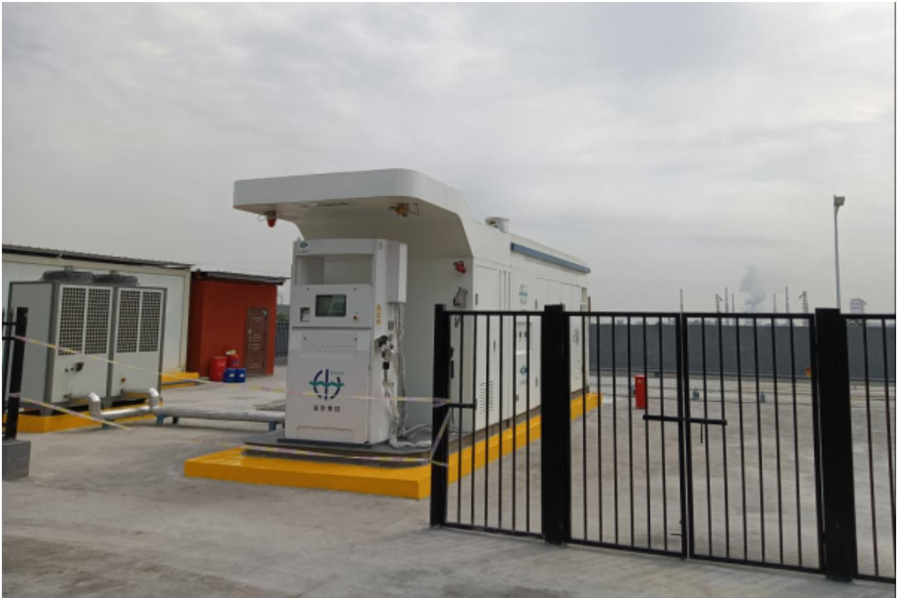
该项目由厚普股份旗下的厚普工程公司提供站点工程设计和工程安装、氢能研究所提供加氢成套设备集成、安迪生公司提供核心部件、厚普技服公司提供售后保障。该站配置45MPa LexFlow液驱式氢气压缩机、一体化撬装方式。并配置一键操作智能化控制系统，安全可靠，操作方便；具有可带载频繁启动特性，适用不同入口压力下的持续稳定工作。
