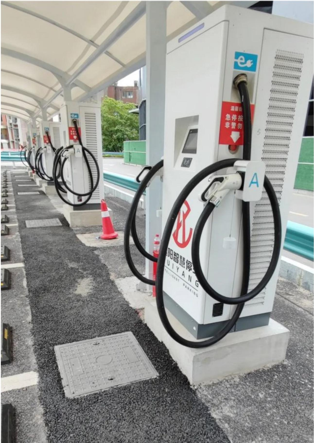
目前，ABB电动交通为本次项目所提供的 ABB Terra系列直流充电桩均在稳定运行中，充电量已突破42万度，助力停车场站破解充电难题。ABB Terra CA/CB系列安全智能直流充电桩适用于集中式充电站场和各类建筑配套，可为私家车、网约车和物流车提供安全便捷的充电服务。其中CA为高配，CB为基本配置，多种功率型号选择，充电方式灵活，可适用于多种场景。
