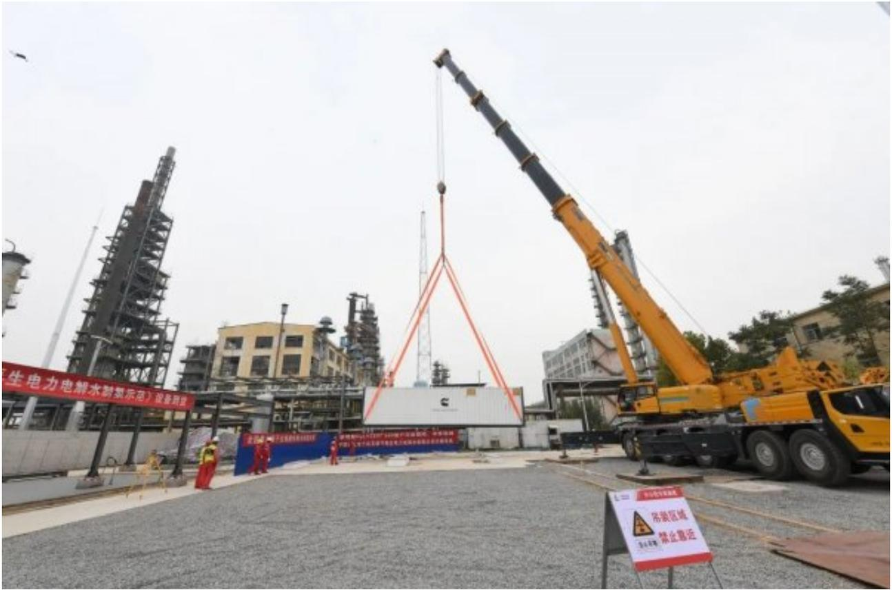
10月30日，中国最大质子交换膜电解水制氢装置、中国石化首个兆瓦级可再生电力电解水制氢示范项目的核心设备——质子交换膜电解水制氢装置完成吊装，这标志着该项目正式转入设备安装调试阶段。
