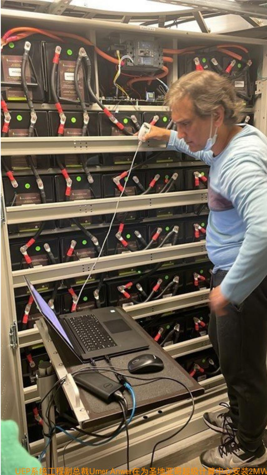
UEP系统工程副总裁Umer Anwer在为圣地亚哥超级计算中心安装2MWh电力备份系统，该中心于2022年上线。
