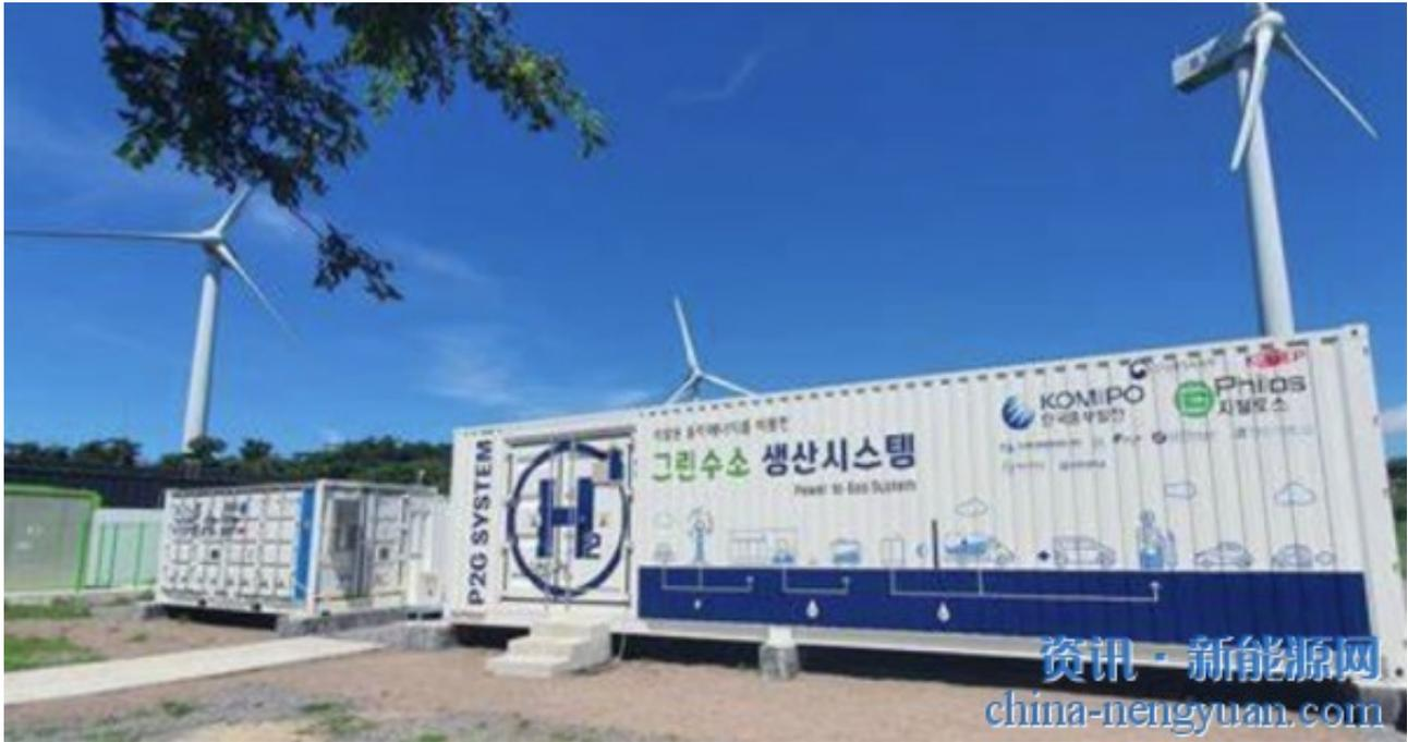
在该项目中，NAS电池作为风力涡轮机和电解槽之间的能量缓冲器，以确保从剩余风电中稳定生产氢气。
