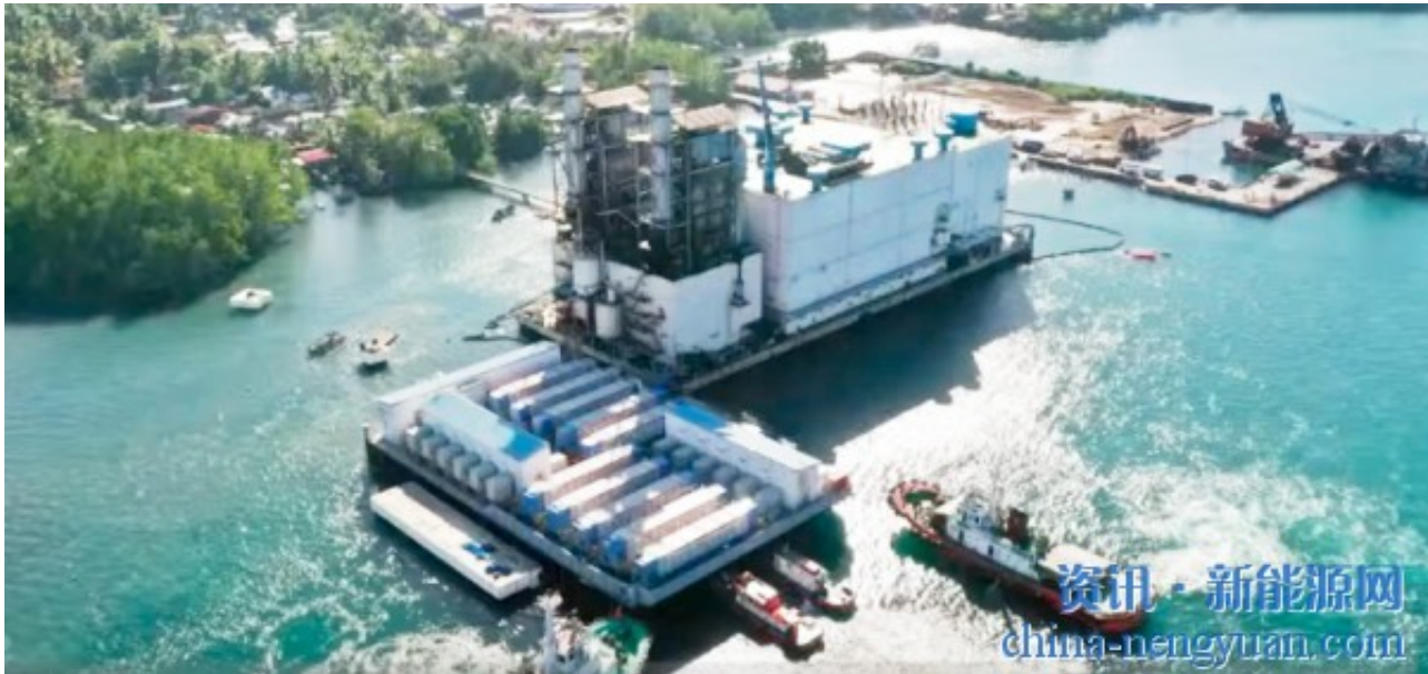
电池存储系统毗邻一个浮动式热电厂。图片来源：Aboitiz Power
