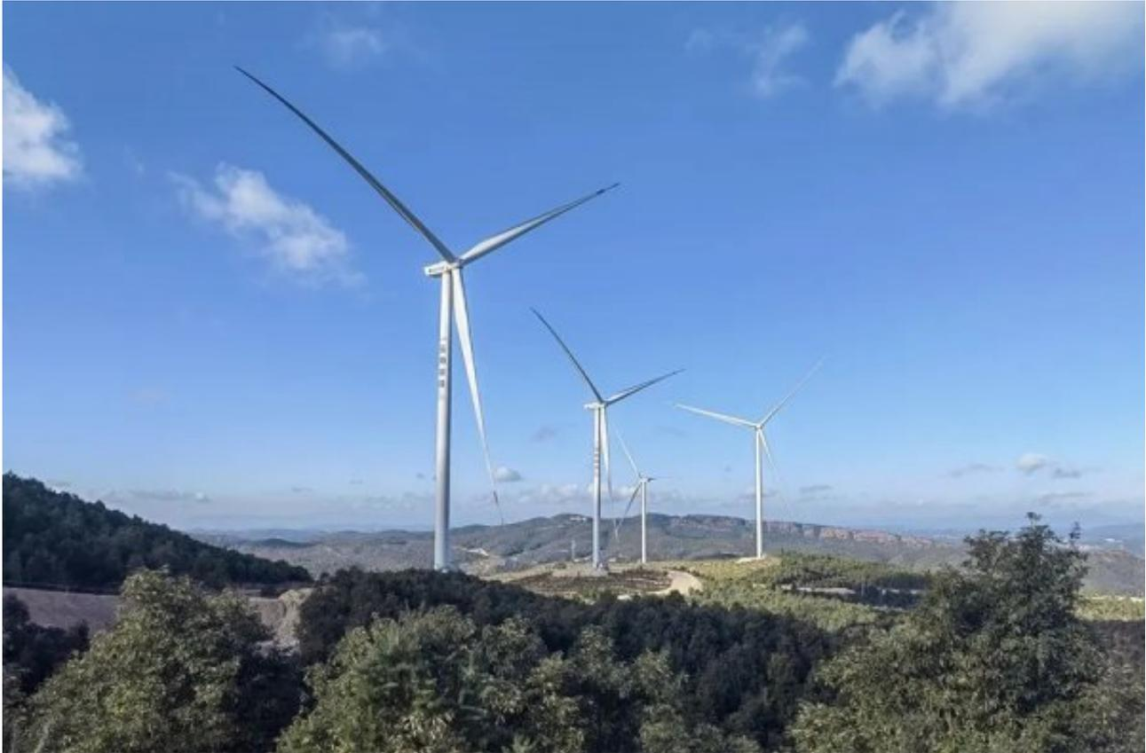
通泉风电项目概算总投资22.4亿元，装机规模35万千瓦，全容量并网后可实现年上网发电量9.67亿千瓦时，年等效满负荷小时数2751小时，每年可节约标煤约29.62万吨，节约淡水117万立方，为全省高质量发展注入绿色动能。在通泉风电现场，一台台轮毂高度120米、叶轮直径185米的超级“大风车”矗立在高山白云间。据了解，每台机组正常转动一个小时，就能发电6250千瓦时。风机塔筒上印有云南能投集团旗下云南盐业的“白象牌”食盐商标，是云南四大绿色食品品牌，产品质量和品牌形象深入人心，充分展现了云南能投集团打造全省绿色能源产业发展主力军和全省绿色食品骨干企业的责任与担当。
