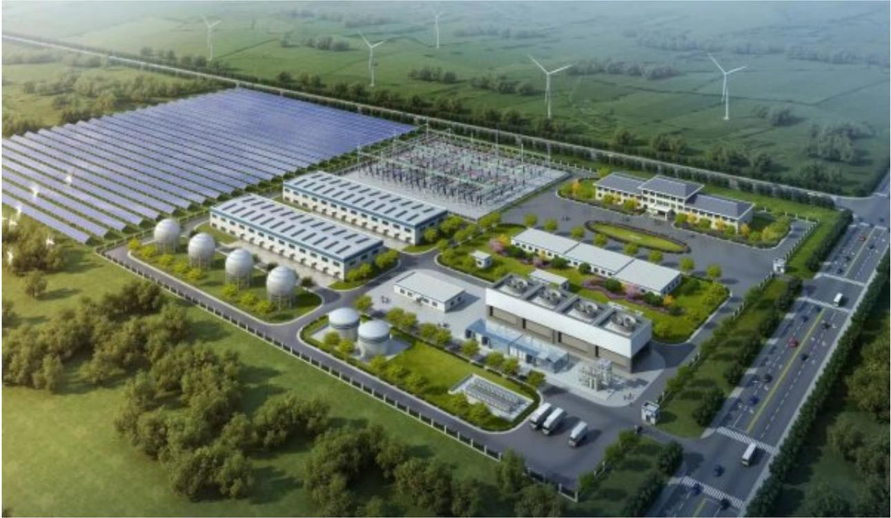
甘肃酒泉风光氢储及氢能综合利用一体化示范工程，由中国能建氢能公司投资建设，规划建设绿氢年产量1.7万吨、绿色合成氨年产量3.9万吨以及配套工程，总投资76.25亿元，其中一期规划建设高压气态氢年产7000吨、液氢年产量330吨、合成氨装机2万吨并配套建设风电85兆瓦、光伏130兆瓦，一期投资23亿元。项目建成后将成为甘肃省首个集气态和液态绿氢、绿色合成氨于一体的氢能综合利用项目，将有助于传统化工产业深度脱碳，完善当地氢能产业链布局，推动当地绿色产品认证体系构建。
