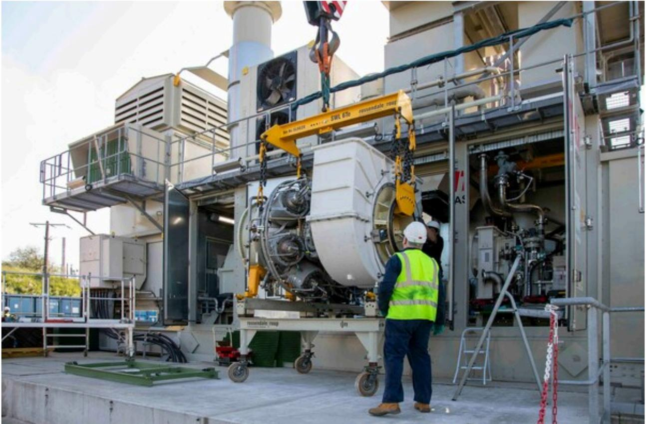
Hyflexpower项目证明绿氢不是一种灵活的储能方式，还可以成为工业型燃气轮机的燃料。由造纸厂电解水制氢设备生产的氢气以30%的比例与70%的天然气混合燃烧，驱动燃气轮机发电。
