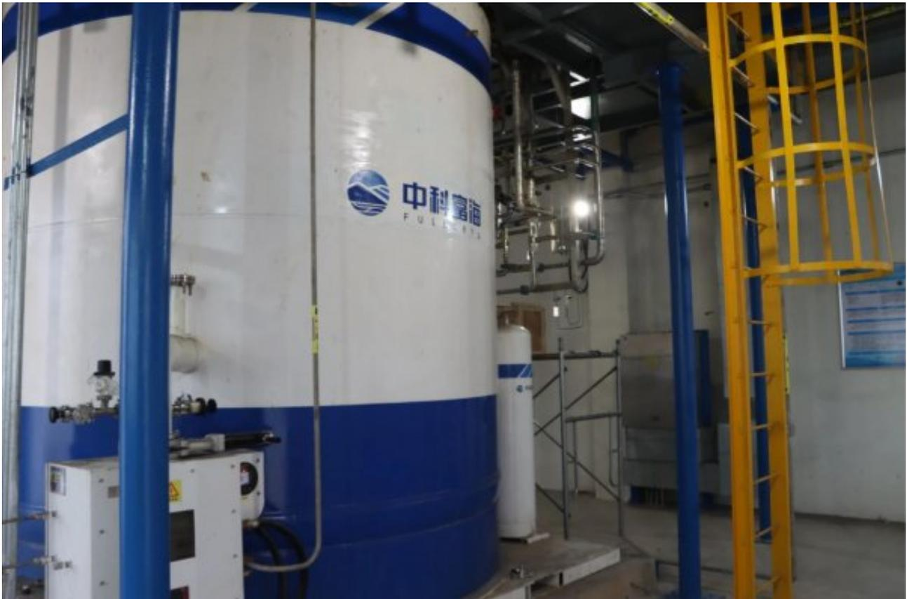
本次运行的1.5TPD氢液化装置，是中科富海三大战略之一的安徽中科昊海高端绿色氢能项目。该装置自2018年开始自主设计研发，于2019年底在中科富海中山装备公司完成核心装备加工、制造，集成氢液化冷箱主体；2022年12月产出液氢产品。实际上，早在2019年1月，由中科富海旗下子公司中科昊海在安徽阜阳启动高端绿色氢能项目，旨在实现高纯气氢和液氢联产的氢能产业链。项目一期包含一套2000m<sup>3</sup>/h氢气纯化装置和1.5TPD氢气液化装置，氢气来源于安徽昊源集团化工副产氢气，中科富海根据原料气源因地制宜，采用成熟、先进的变压吸附氢气提纯技术，于2022年1月已成功生产出纯度5N以上的氢气产品。随着1.5TPD装置的调试成功，一期项目高纯氢与液氢联合生产基地实现全部投产，预期氢气纯化装置可年产高纯氢气9760000（折合标态）Nm<sup>3</sup>，液氢可达年产3240000（折合标态）Nm<sup>3</sup>的生产能力，除服务于氢燃料电池汽车加氢站外，基于液氢汽化后显著的纯度优势，将满足光纤、半导体和集成电路等产业对6N级乃至更高纯度要求的氢气供应需求。
