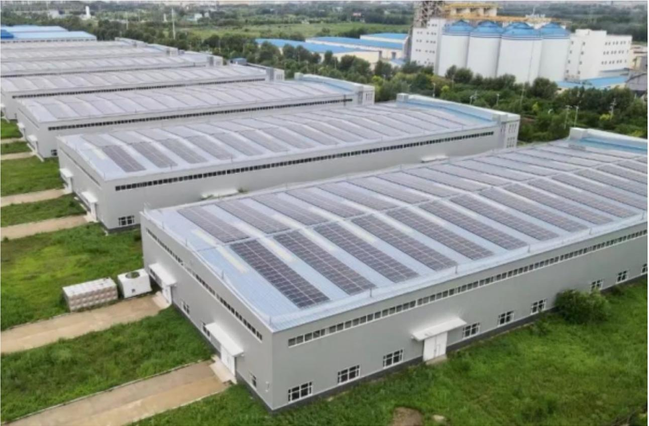
该项目位于白城市工业园区，总占地面积8600平方米，采用绿电“优先制氢、余电上网”的新能源运行方式与“光伏+风电、碱液+PEM制氢”双耦合制氢模式。建设容量10.6兆瓦，其中风电6.6兆瓦、光伏4兆瓦，配套建设单台设备出力为1000标立方的碱性电解水制氢设备1台和单台设备出力为200标立方的PEM纯水制氢设备1台。截至目前，光伏部分已全容量并网、碱液制氢设备投入运行，二期两台3.3兆瓦风电及PEM制氢设备预计年内建成。
