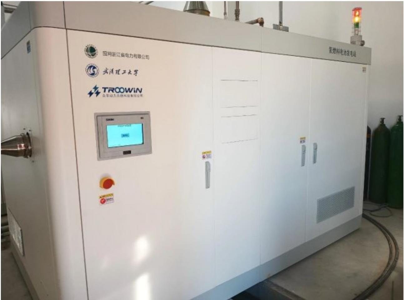
作为此次国家重点项目的配套企业，众宇依托自身在氢能及燃料电池领域技术与产品开发的优势和经验，基于发电装置特性与实际需求，在考虑效率、稳定、空间布局等因素的前提下，针对电-热负荷分布及需求情况提升系统综合能效，从方案论证、设计开发、建模仿真到电堆优化与BOP选型等，全新开发了氢燃料电池热电联产系统——这也是众宇首套固定式热电联产系统，采用模块化开发理念、集中燃料供给与热处理设计，设计寿命6-8万小时，可并联扩展至2.5MW级，具有效率高、成本低、寿命长、可靠性强等优点，电效率可达50%以上、热电联供效率可达95%以上。
