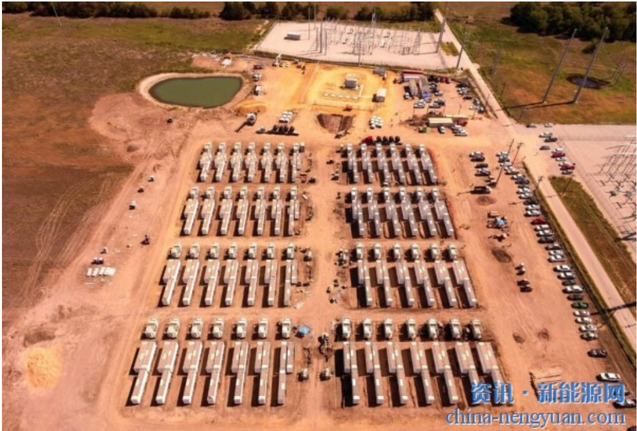
德克萨斯州190MW/380MWh电池存储基地正在建设中。图片来源：Qcells USA
