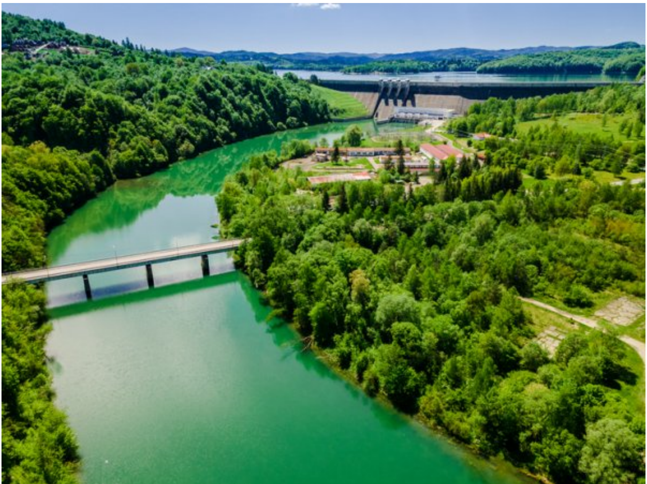
图1.索利纳水力发电厂是一座具有抽水组件的峰值负荷发电厂，在波兰电力系统中发挥着重要作用。该电厂最初的发电能力为136MW，但现代化改造将其增加到200MW。该电站由四个水力发电机组组成，位于波兰最高的重力坝脚下。可用水头为60米。该工厂的高海拔水库是波兰最大的人工湖。图片来源：Envato Elements
