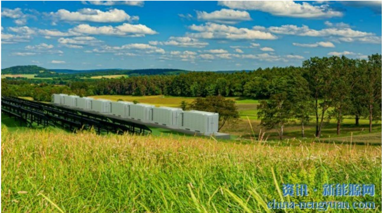
同步调相机(Synchronous condenser, SC)技术和电池储能系统(BESS)在混合配置中相互补充。这提供了一系列电网支持功能，包括黑启动功能。ABB同步调相机专家Christian Payerl解释道。
