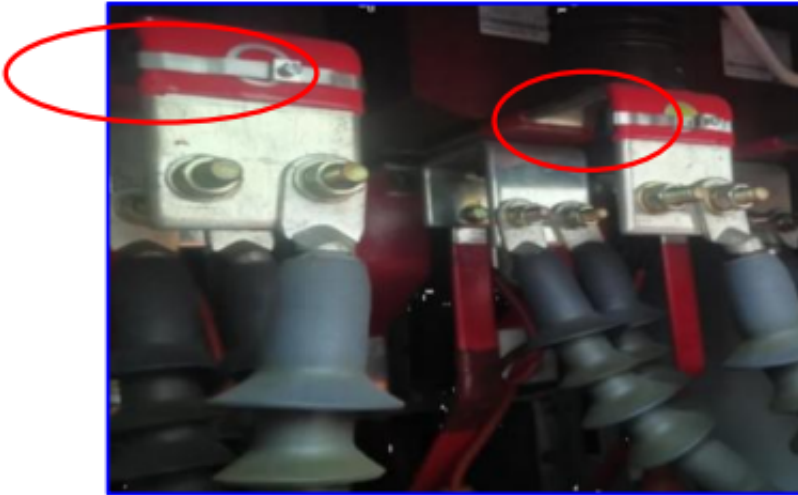
图3 测温传感器安装位置（红圈所示）
