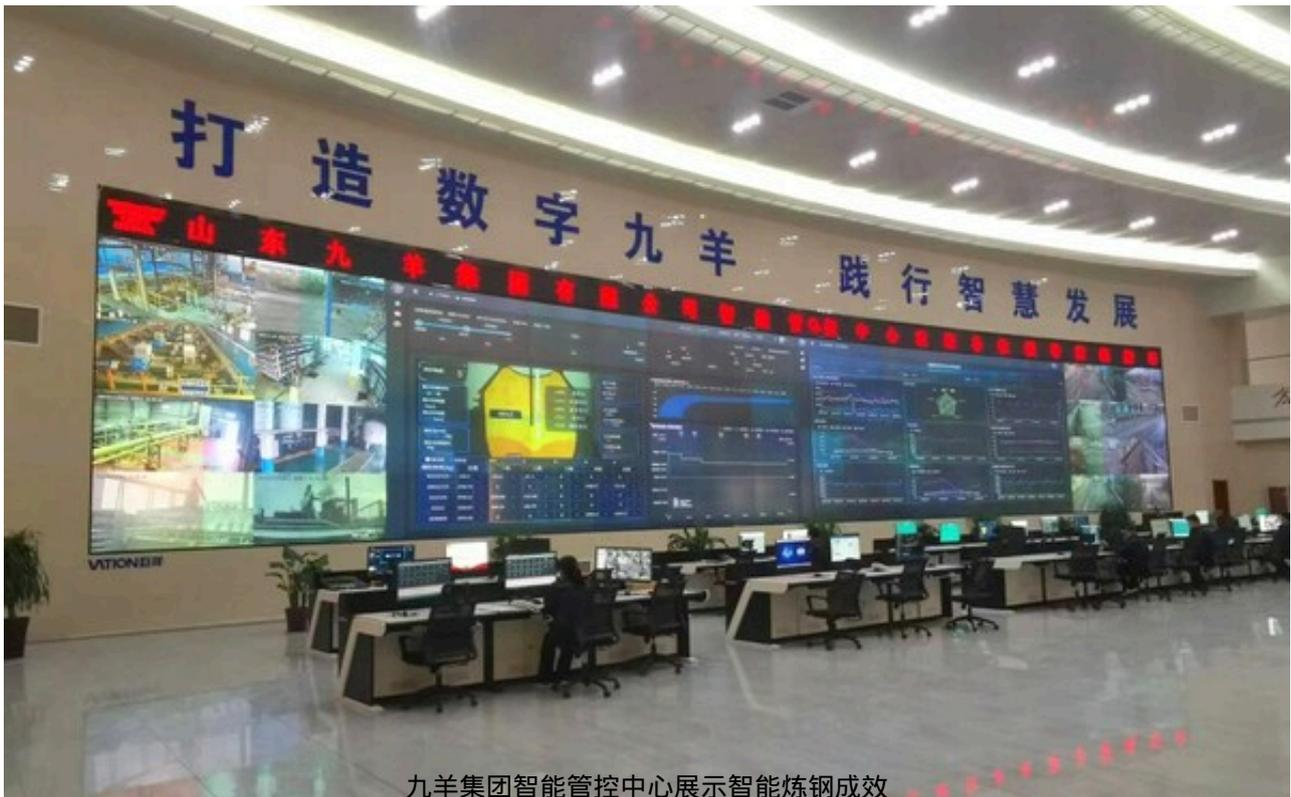
《报告》指出，工业边缘在工业企业的生产管理、工业控制、物流管理和现场管理等4个方向形成诸多应用场景。列举了多个优秀案例的先进做法，给更多企业提供借鉴参考。其中“工艺优化分析-九羊钢铁炼钢智能过程控制”入选工业边缘典型应用场景案例。山东九羊集团有限公司携手浪潮云洲，面向工艺优化分析这一工业边缘场景，建立“精益+智能”服务模式，应用智能炼钢系统，沉淀冶金专家知识及炉长操作经验，结合机理模型和机器学习算法，自动选择最优化配料方案、投料模式及操作规划，实现转炉生产数字化与智能化，转炉终点的碳、温双命中率提高至88%，冶炼时间缩短8-10%。
