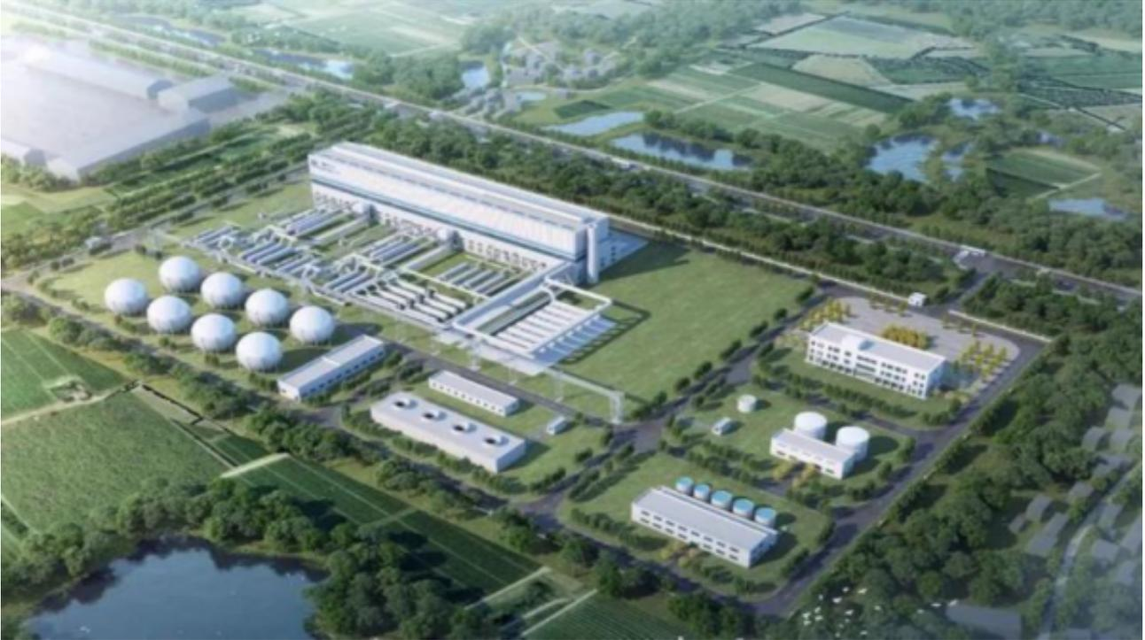
湖北应城300MW级压缩空气储能电站示范工程是世界首个300MW级非补燃压缩空气储能电站，建成后预计年发电量可达5亿千瓦时，将在非补燃压缩空气储能领域实现单机功率世界第一、储能规模世界第一、转换效率世界第一，为大规模、长时物理储能技术发展起到积极的示范及推动作用。
