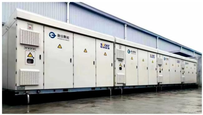
2023年初,蜂巢能源与融合聚能签订了分布式储能电站项目战略合作协议。该项目储能规划容量为14.14MW/29.27 MWh,采用蜂巢能源单元储能系统,并网电压等级为10kV。3月24日,融合聚能完成广东美的制冷设备工厂一期13.14 MW/27.02MWh储能电站并网投运,二期设备正在交付中,储能规划容量为1MW/2.25MWh。
